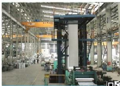
Nhà máy tôn thép
